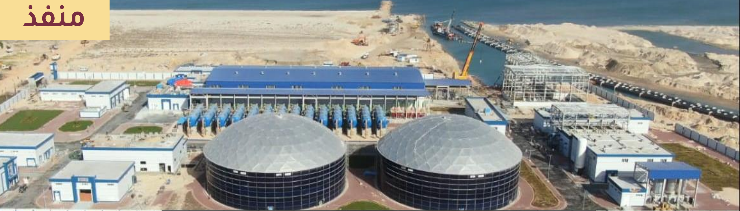
محطة تحلية مياه البحر بالعريش بطاقة ( ١٠٠ ألف م ٣ /يوم)
